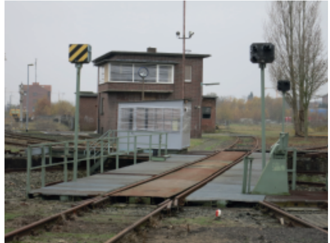
Photo (Peter Tadsen): Drehscheibe und Lokleitung
